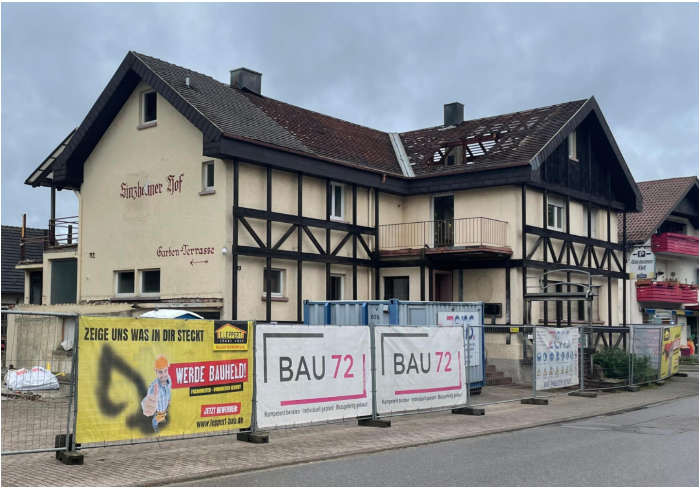
Der Sinzheimer Hof muss weichen. Anstelle des früheren Gasthauses soll hier ein Mehrfamilienhaus mit zwölf Wohnungen entstehen. Den Bau übernimmt die Firma Bau 72 aus Iffezheim. Foto: Nina Bossert
